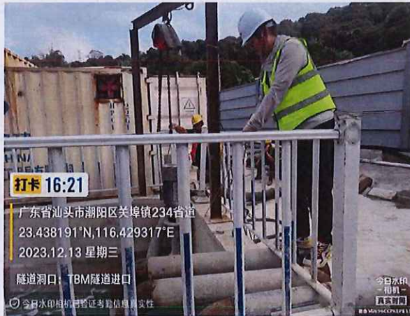
施工 5 标 TBM 隧道开端洞口排水
