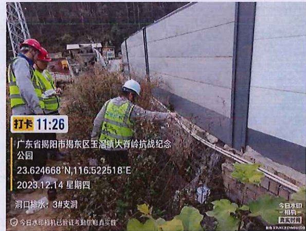
施工 1 标 3#支洞隧道洞口排水
