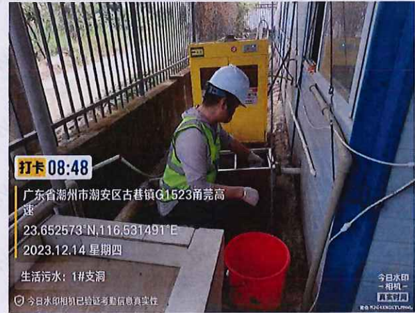
施工 1 标 1#支洞厨房生活污水
