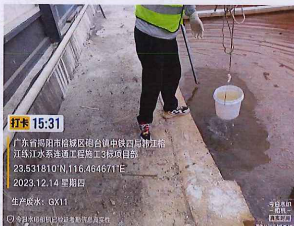
施工 2 标 GX11 生产废水
