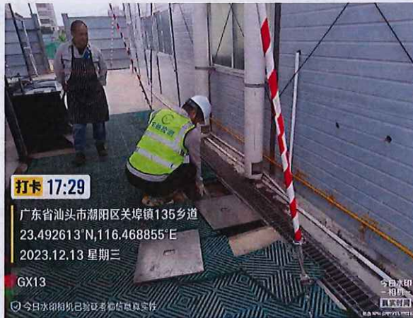
施工 4 标 GX13 厨房生活污水
