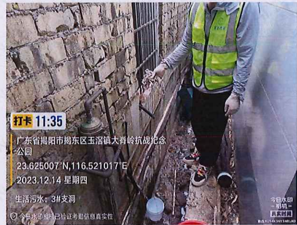
施工 1 标 3#支洞厨房生活污水
