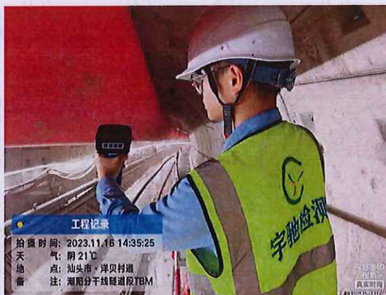
TBM 隧洞洞口开端 150 米处
