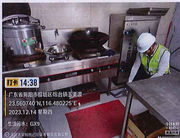
施工 3 标 GX9 厨房生活污水 (2 号点)
