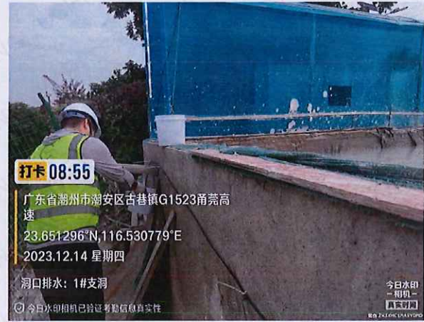
施工 1 标 1#支洞隧道洞口排水
