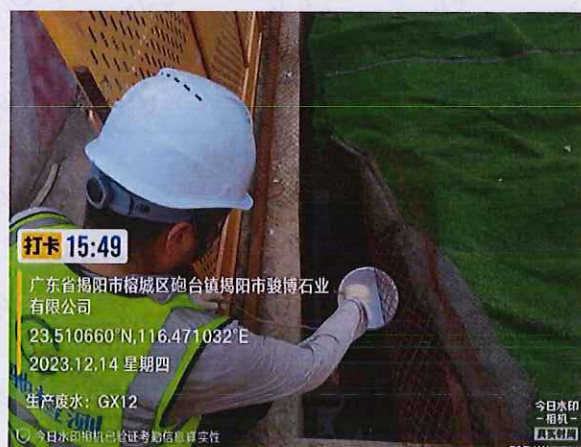
施工 2 标 GX12 生产废水
