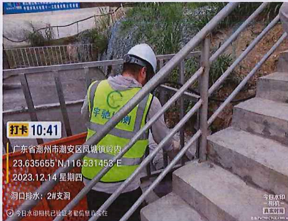
施工 1 标 2#支洞隧道洞口排水
