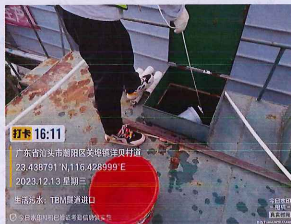
施工 5 标 TBM 隧道开端生活污水
