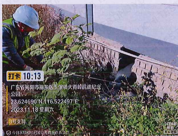
施工 1 标 3#支洞隧道洞口排水
