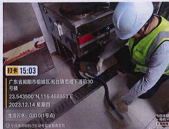
施工 3 标 GX10 厨房生活污水 (1 号点)
