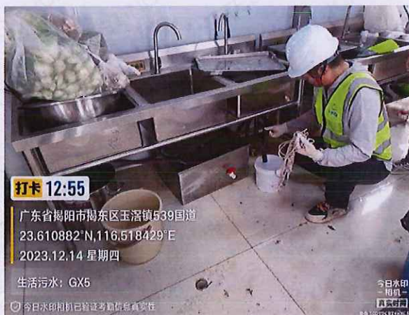
施工 3 标 GX5 厨房生活污水
