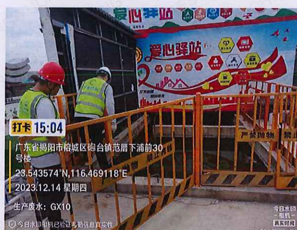
施工 3 标 GX10 生产废水
